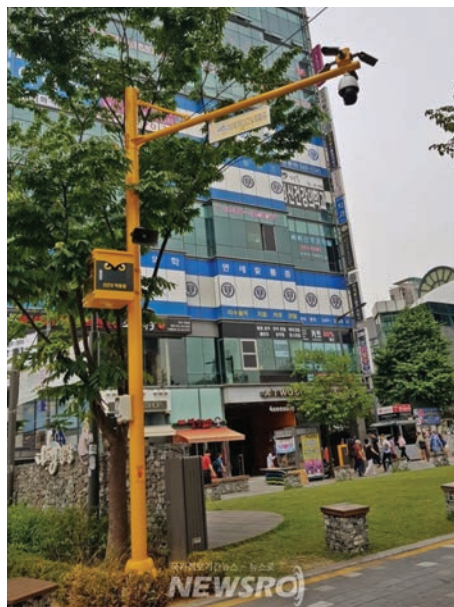
통합관제 센터와 연결, 고화질 다목적 CCTV, LED 안내판, 로고라이트를 설치한 통합방범장치 설치 [경기도 부천시]
