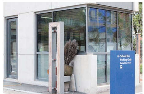
주,부 출입구 경비실 3면 이상 투시형 구조로 디자인과 CCTV 모니터링 시스템 설치
