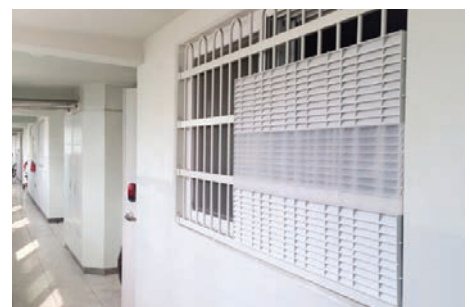
편복도에 면한 단위세대의 창문에 강화된 보안장치 설치
