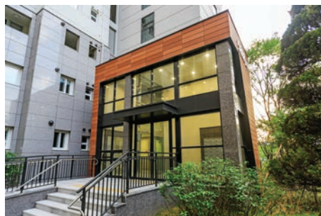
내부가 보이도록 계획된 돌출형 주동 출입구 [위례 자연& 래미안 e편한세상]
