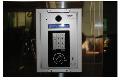
주동 출입구에는 접근통제 시설 설치
