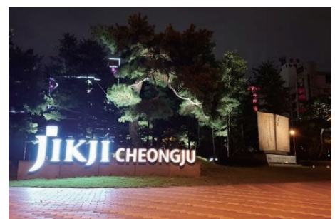
공원 출입구와 경계를 구분할 수 있도록 적당한 조도 확보 및 CCTV 설치
