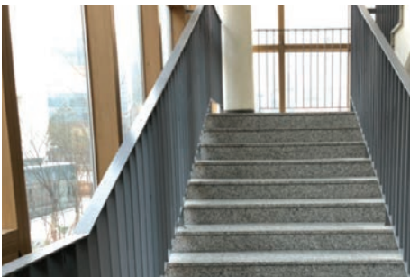
복도 및 계단실에는 전면 투시형 창문 설치 [화성시 동탄중앙초등학교]
