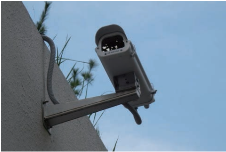
단지 경계부 담장에 방범용 CCTV 설치
