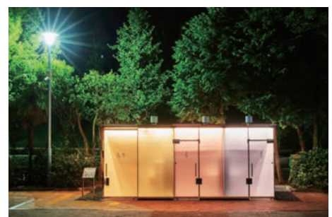
화장실 내외부 상시 조명 설치와 주변 시야 확보를 위한 가로등 설치
