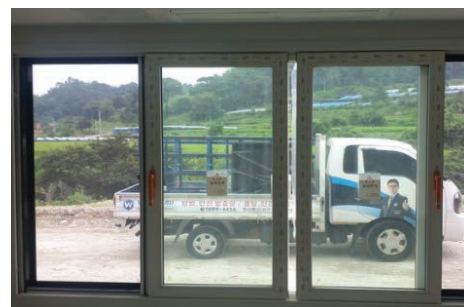
스텐레스망과 이중잠금장치가 설치된 창살없는 방범창 [왼쪽: 외부/오른쪽:내부]
