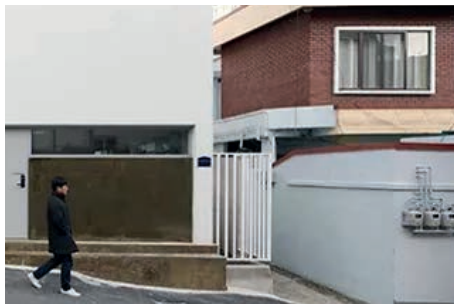
주택사이 이격공간에 투시형도어 설치 [경상남도 창원시]
